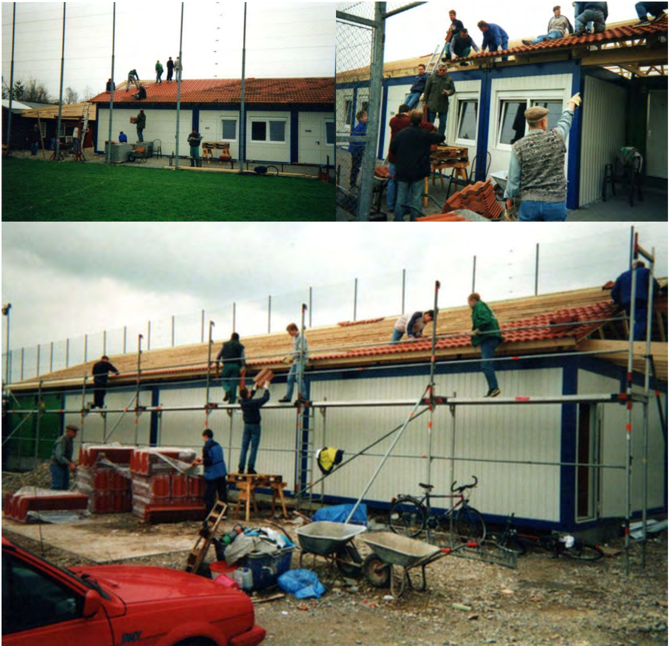
Bild: Neubau der Kabinen mit Containern und stabilen Dach
